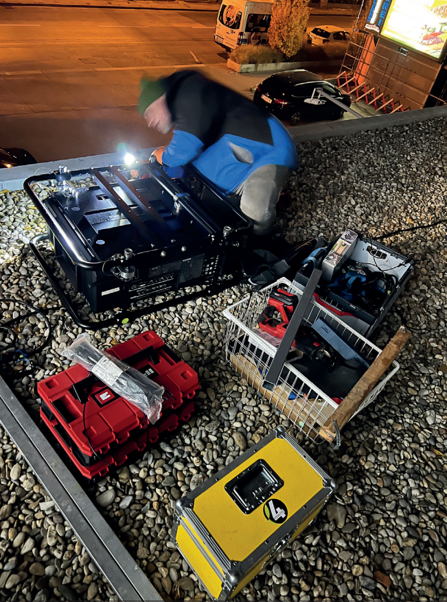
Der bleibt stehen: Projektor während der Installation, bevor er im Wetterschutzgehäuse eingeklemmt wird.
